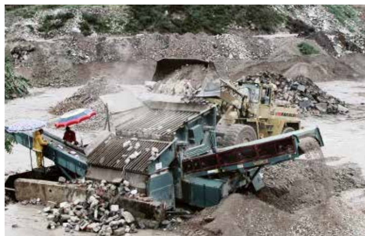
Bauschuttzubereitung in Marktzeuln
